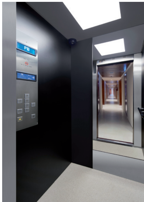
Sustitución de paneles manteniendo la botonera original
